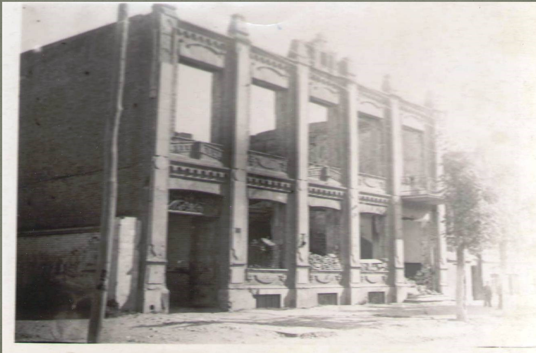
Разрушенное немецко-фашистской авиацией в 1942 году здание штаба 74-го батальона
